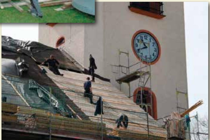
Jöhstadt: Arbeiten auf dem Dach
